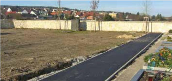
Die Arbeiten im Friedhof schreiten zügig voran – die Wegearbeiten wurden Anfang Dezember abgeschlossen. Gleichzeitig wurden Anschlüsse für die geplante Beleuchtung entlang der Strecke vom Eingang Gedächtnisstätte bis zum Eingang Leichenhalle verlegt.
